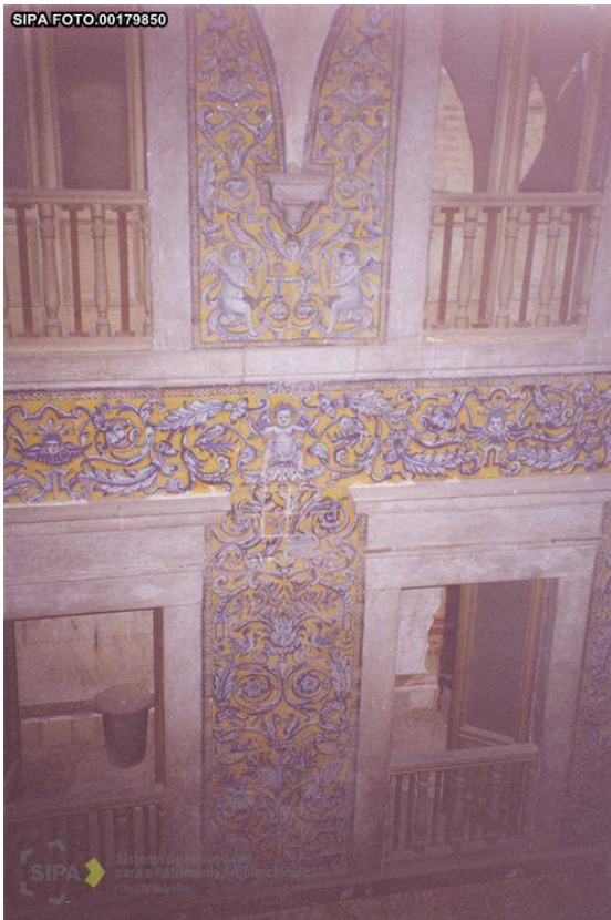
Fotografia nº 105 – Pormenor dos azulejos tipo “padrão” no interior da Igreja de São Lourenço, Lisboa.
