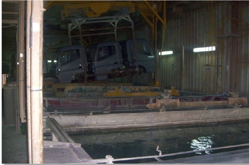
FIGURA 4.7 - ALGUNS DOS BANHOS DA LINHA DE E/D
