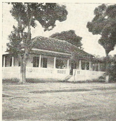
Residência de um delegado de saúde, no interior da província The residence of a doctor from the health service in a rural zone of the interior
