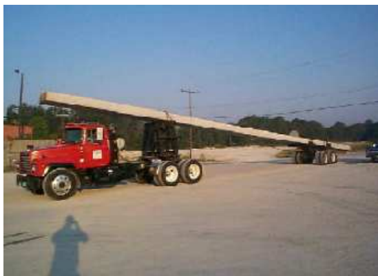
Figura 2.11 - Transporte especial para elemento pré-fabricado de grandes dimensões (extraída de [28])
