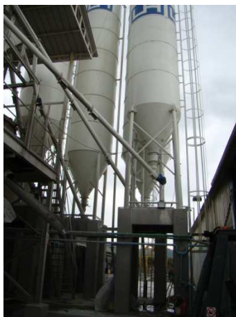
Figura 2.4 – Silos de armazenamento da fábrica da Luso Alemã
