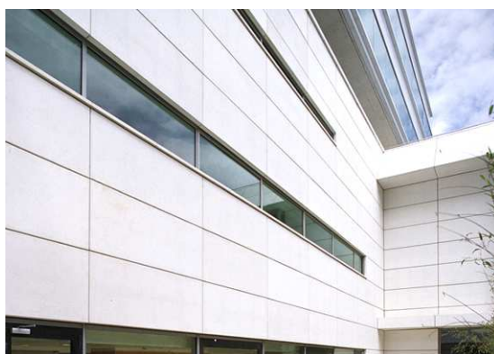
Figura 6.14 - Exemplo de aplicação de painéis GRC comercializados pela PRÉGAIA (extraída de [69])
