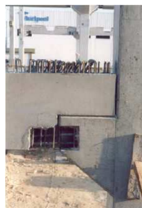
Figura 5.5 – Ligação seca (extraída de [30])
