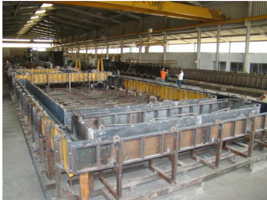
Figura 2.9 – Molde para execução de um pórtico pré-fabricado na empresa Luso Alemã
