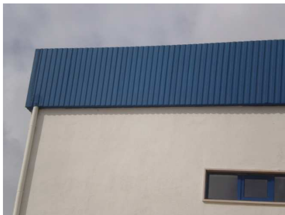
Figura 8.2 – Ligação directa ao tubo de queda
