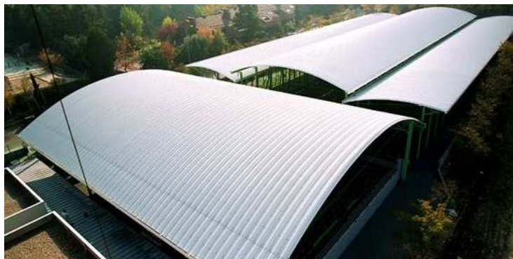
Figura 6.6 – Exemplo de aplicação de perfis ómega em coberturas industriais (extraída de [42])
