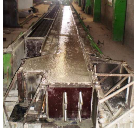
Figura 2.8 – Molde de fabrico de pilares na fábrica da Concremat
