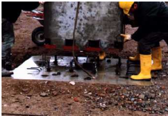
Figura 2.14 – Posicionamento e estabilização numa ligação pilar - fundação (extraída de [28])
