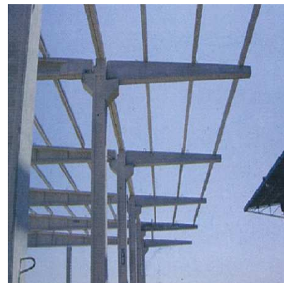
Figura 4.12 – Vigas para beirais (extraída de [44])
