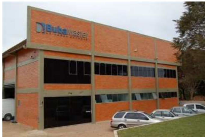
Figura 3.8 – Edifício industrial misto (extraída de [63])
