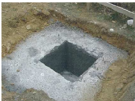
Figura 4.2 – Sapata betonada “in-situ” (extraída de [41])
