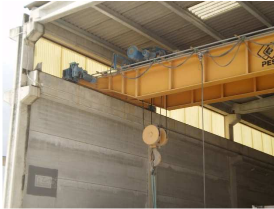
Figura 4.10 – Viga rectangular com extremidade reentrante
