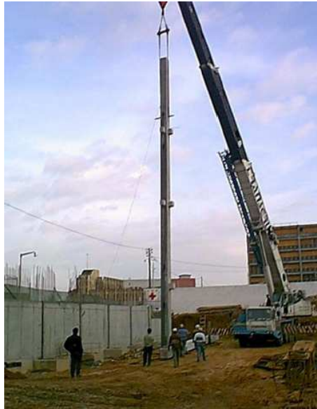
Figura 2.13 – Elevação de pilar (extraída de [28])
