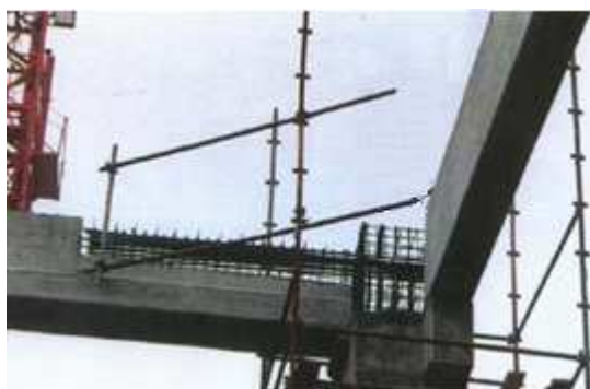
Figura 5.4 – Ligação húmida (adaptada de [30])
