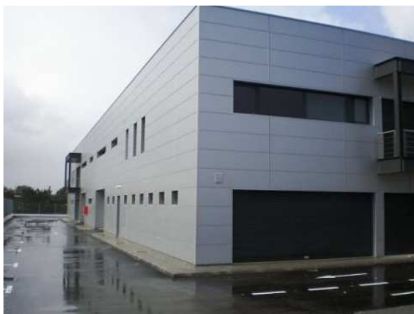
Figura 6.10 – Aplicação de painel sandwich WALLTEC (extraída de [65])
