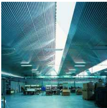
Figura 8.6 – Exemplo de cobertura SHED em edifícios industriais (extraída de [6])
