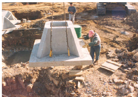
Figura 4.1 - Sapata pré-fabricada em cálice (extraída de [11])
