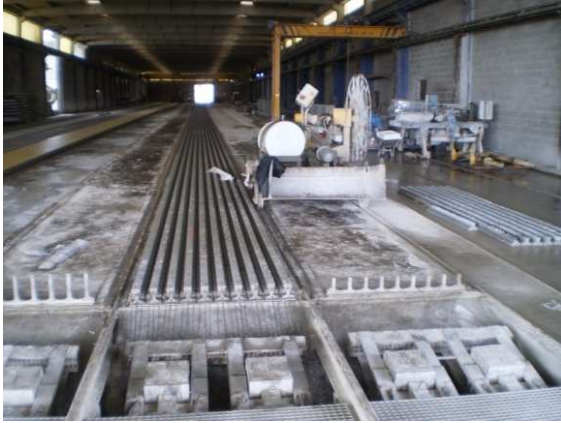
Figura 2.7 – Mesas de fabrico de vigotas e de madres pré-esforçadas na fábrica da Secil Prébetão
