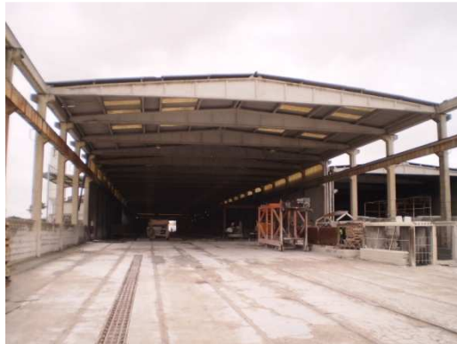
Figura 3.3 – Edifício industrial pré-fabricado em betão
