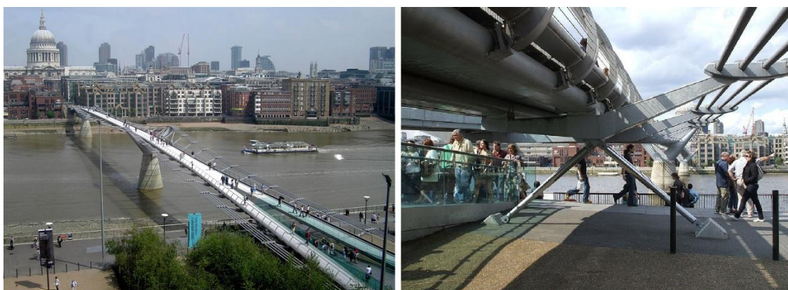
Figura 3-3 - Millennium Bridge em Londres após instalação dos amortecedores viscosos [30,67]
