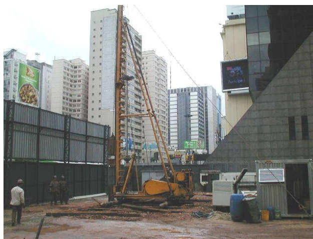
Figura 3-5 - Cravação de estacas em zona urbana [53]
