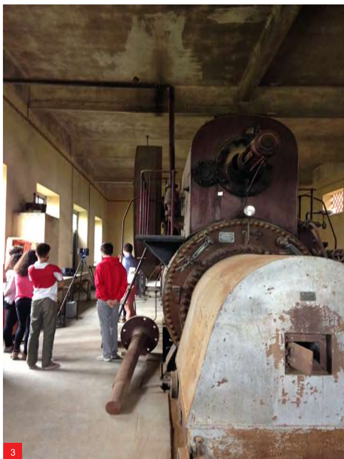
3 | Explicação, demonstração e experimentação do processo de documentação por scanner-laser da sala da máquina a vapor da Fábrica de Descasque de Arroz da Casa Cadaval, Muge, Salvaterra de Magos.
