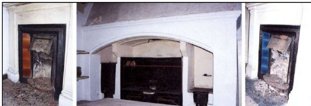
Fig. 4.15 – Arquitectura de tradição clássica da Mina de S. Domingos: Fogões de sala e chaminé da Cozinha no interior do palácio do director da Mina (bairro inglês).
