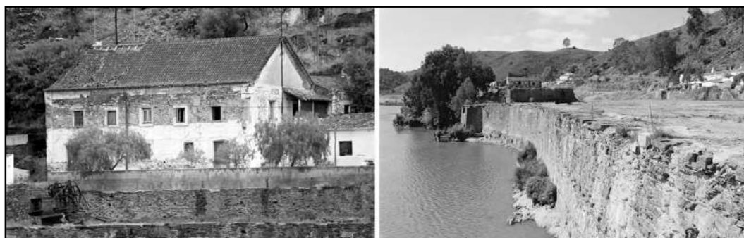
Fig. 3.44 – Casa da administração (palácio da Mason & Barry), e paredão do cais de acostagem do Pomarão, na actualidade.
