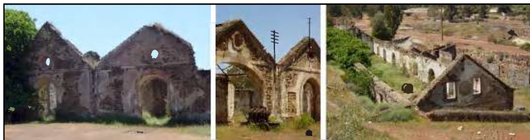
Fig. 4.25 – Arquitectura industrial da Mina de S. Domingos: Oficinas e armazéns em ruínas.
