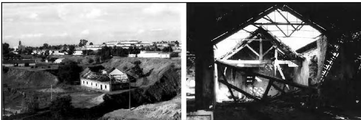
Fig. 5.1 – Ruínas do edifício dos estábulos após o abandono do complexo mineiro. (Fotografias de GV)
