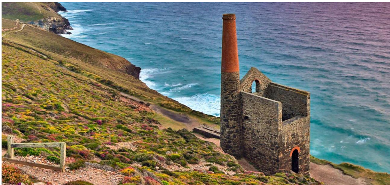
Figura 2.3 - Chaminé com dois tipos de alvenaria, em Inglaterra [W2].
