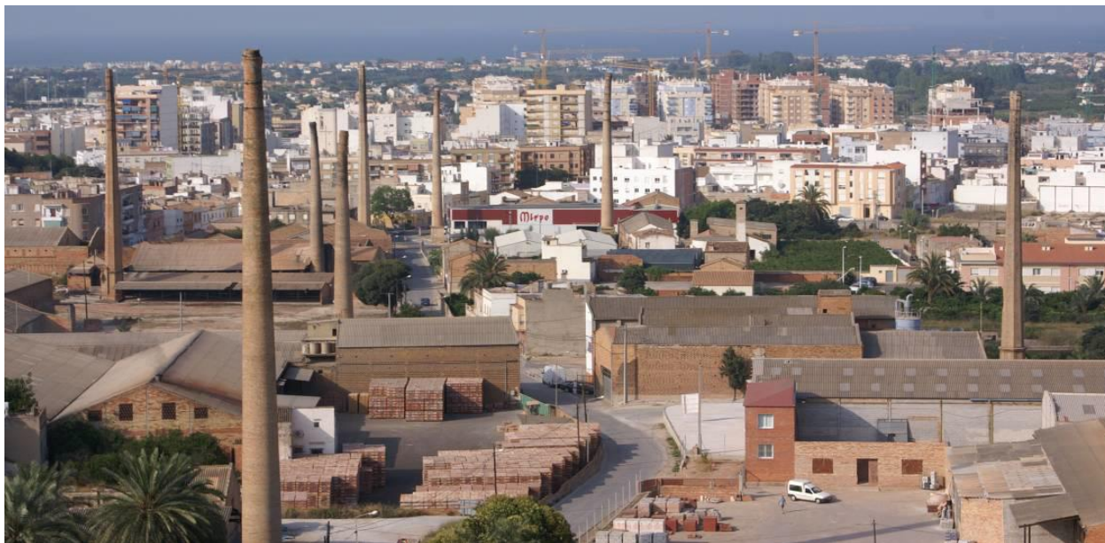
Figura 2.11 - Chaminés em Valência-Espanha. Perda de verticalidade no fuste das chaminés. (Ivorra, 2014).
