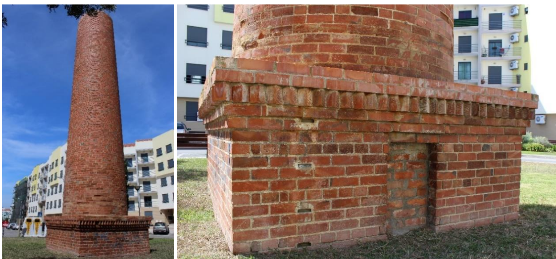
Figura 4.7 - Vista geral da chaminé (à esquerda) e vista geral da base da chaminé (à direita).
