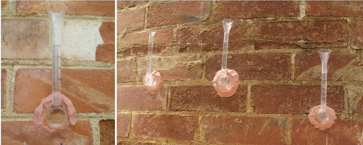
Figura 4.11 - Fixação dos tubos de Karsten na parede de alvenaria.
