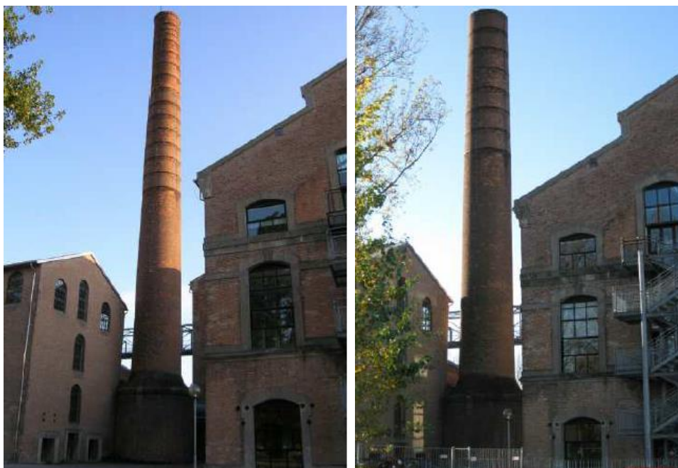
Figura 2.15 - Chaminé em Itália antes e após encurtamento (Bertolesi et al., 2015).
