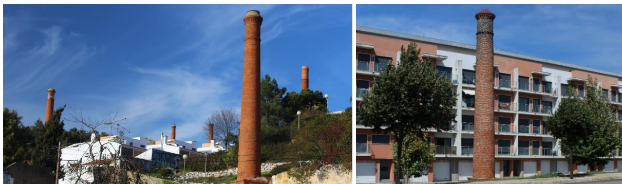
Figura 2.1 - Chaminés inseridas numa urbanização, em Setúbal (à esquerda) e uma chaminé junto a um edifício, no Montijo (à direita).
