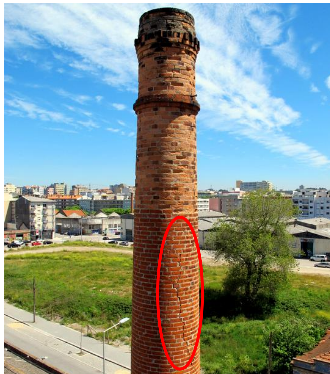
Figura 2.16 - Chaminé em Matosinhos com zonas de tijolos distintos [W3].
