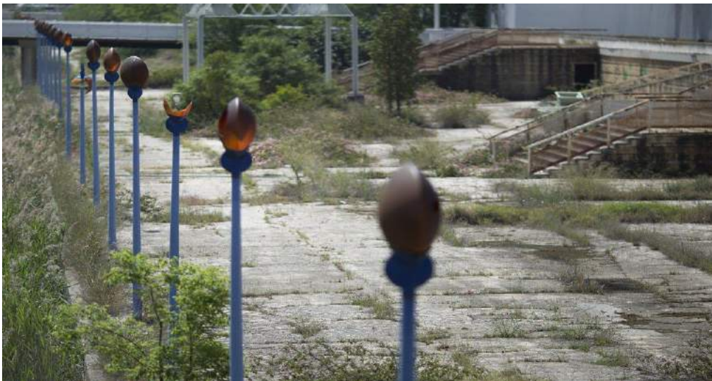
Figura 3.24 - Muitos postes de luz do recinto ainda estão de pé, embora em desuso e destruídos pelo tempo e atos de vandalismo.
