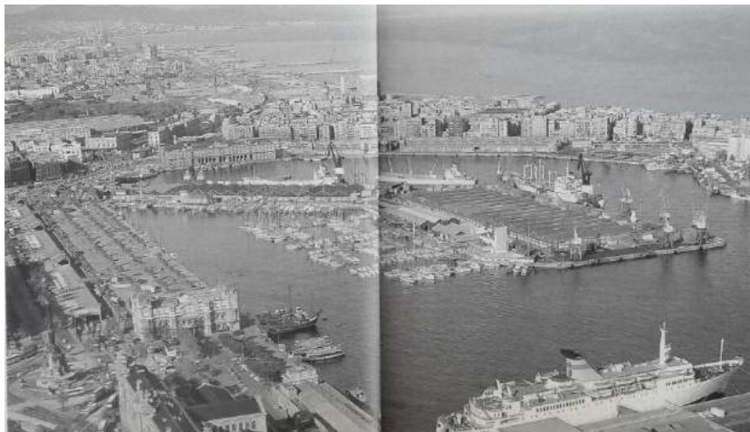
Figura 2.5 – Vista do Porto Vell (s.d). Projecto de RU. (Brutomesso, 1991)
