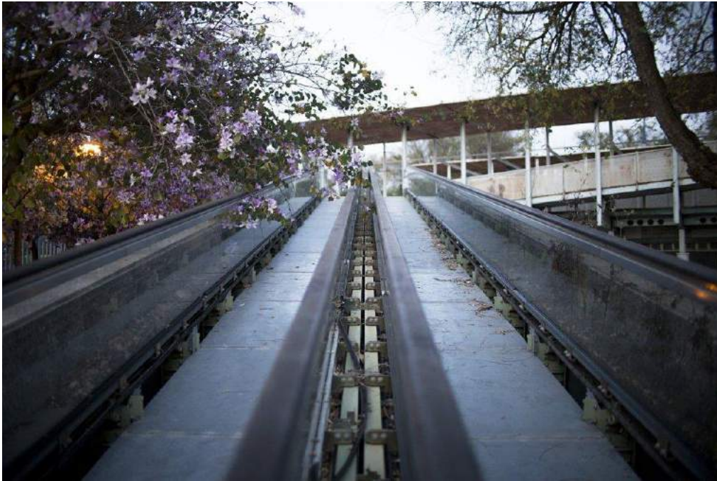
Figura 3.23 - Rampas mecânicas de acesso à estação de monotrilho entre a Rua Tomás Alba Édison e a Avenida dos Descobrimentos.
