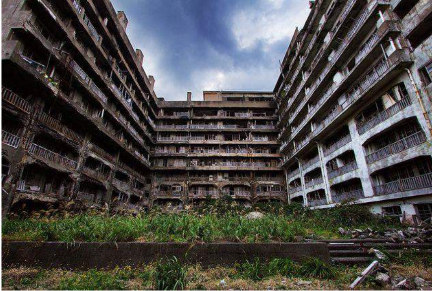
Figura 2.2 - Local abandonado perto da cidade de Nagasaki. Fotografia Chris Luckhardt.
