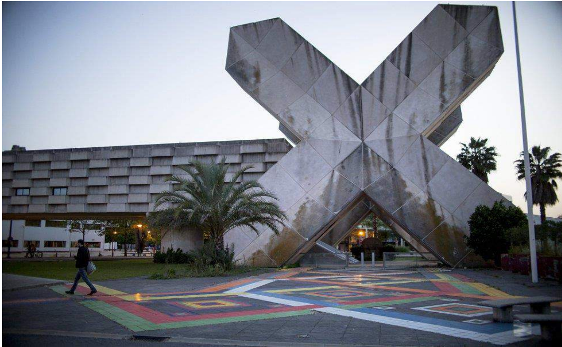
Figura 3.22 - Estado atual do Pavilhão do México, agora em desuso.
