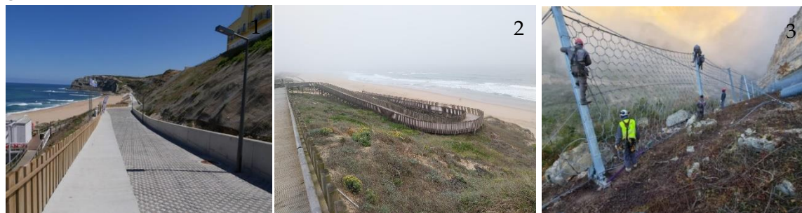
Figura 2.6 - Soluções para a proteção de arribas (1 - reperfilamento, 2 - vegetação, 3 - barreiras dinâmicas).
