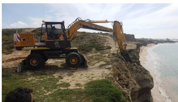
Figura 2.5 - Soluções para a proteção de arribas (saneamento de blocos). Fonte: Câmara Municipal de Peniche (2018).
