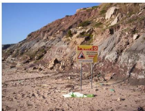
Figura 2.4 - Placa de aviso degrada. Fonte: APA (2012).
