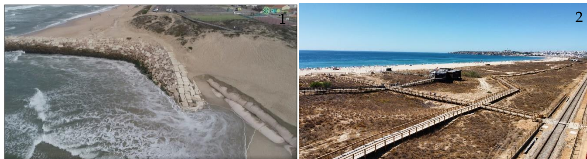
Figura 2.3 - Soluções para a proteção de dunas (1- geotubos colocados a sotamar do esporão na praia da Cova Gala, Figueira da Foz, 2- recuperação dunar). Fontes: 1) T. Mesuras & Cruz (2019); 2) Mota-Engil ATIV (2023).
