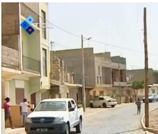
Figura 5.32 - Habitação multifamiliar no bairro Achadinha Pires. (RTC, 2012).
