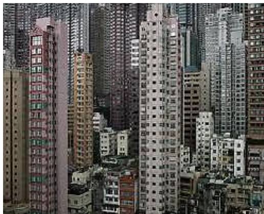
Figura 2.22 - Imagem parcial de Hong Kong, China. Fonte: Google Earth, [10-10-2012]
