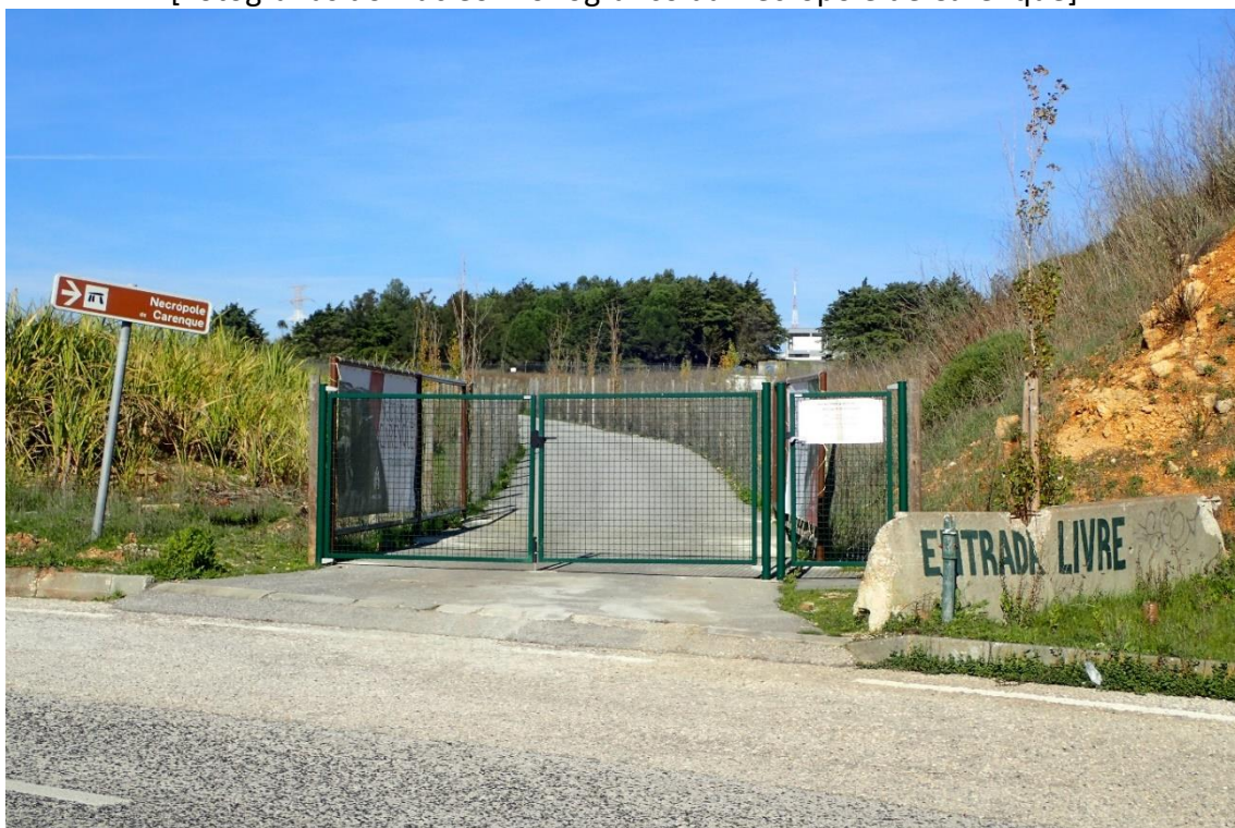
Imagem 13 – Vista do primeiro portão de acesso ao NMNC. © MMAR
