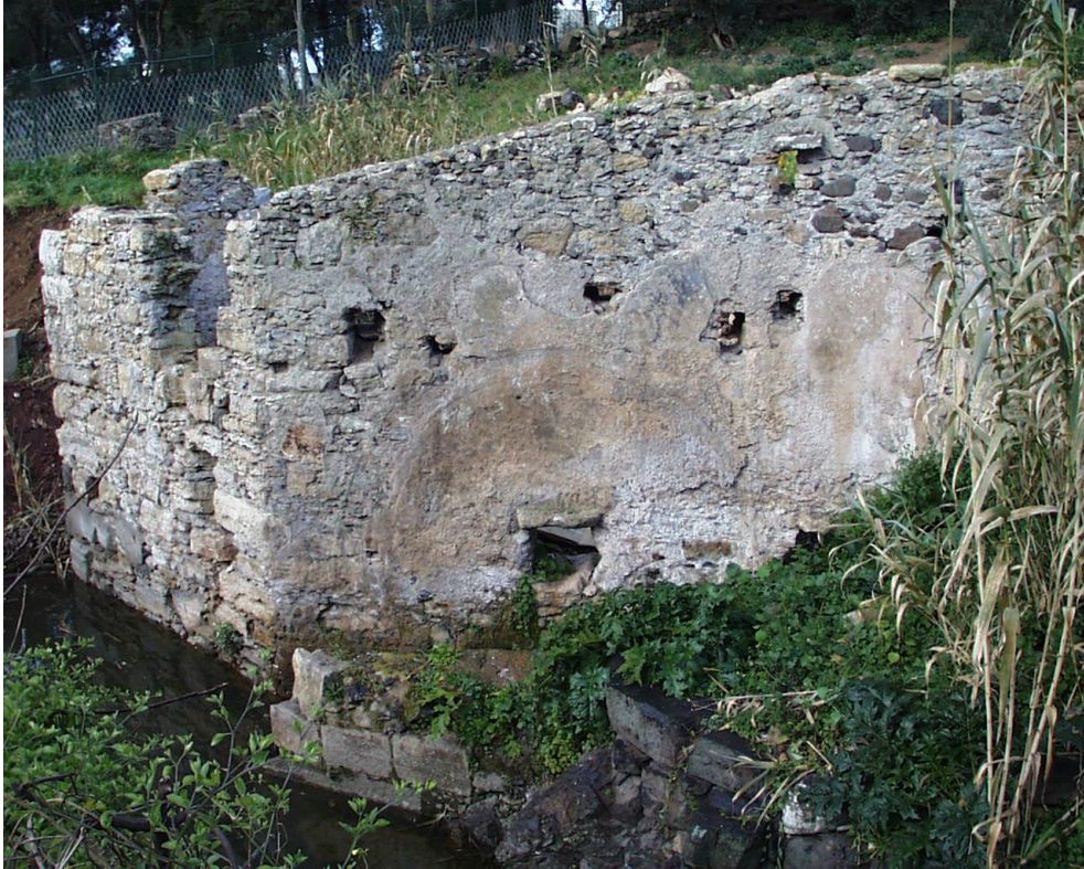
Imagem 61 – Vista exterior da azenha da Falagueira. © MMAR
