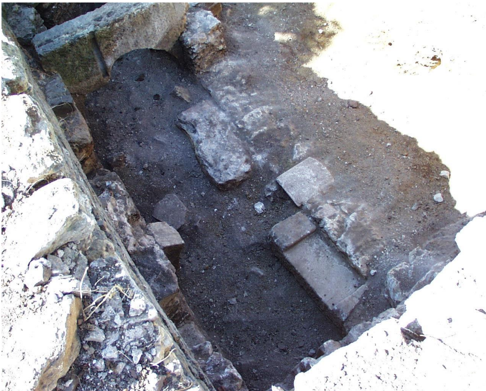
Imagem 62 – Vista interior da azenha da Falagueira. © MMAR
