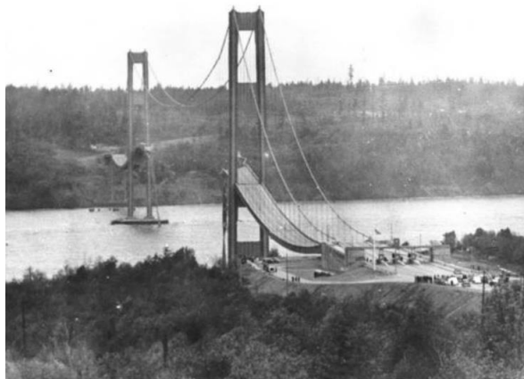
Figura 2 - Queda da Ponte Tacoma Narrows após estar sujeita a vários carregamentos dinâmicos por ação do vento [4]
