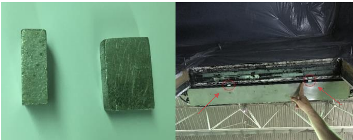
Figura 7 - calços para ajuste de espessura do bocal do jato pretendida (os calços apresentados têm 10 mm de espessura).
