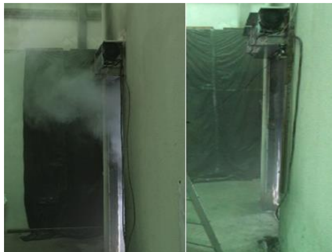
Figura 11 - Cortina ar de sub-dimensionada (esquerda) e cortina de ar com velocidade ótima de funcionamento (direita).
