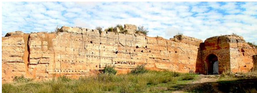
Figura 2.3 - Castelo de Paderne feito em Taipa - origem árabe, construído entre o séc. XI e XII
