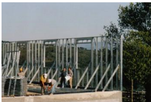
Figura 3.8 - Colocação da estrutura das paredes [45]
