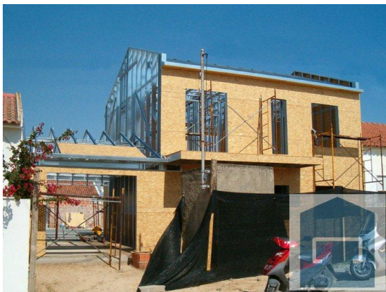
Figura 3 – Colocação de OSB
