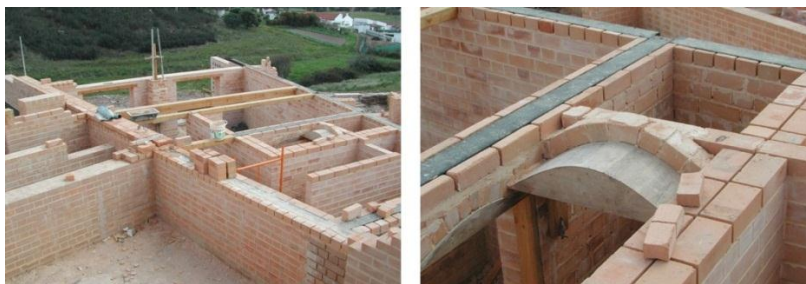
Figura 2.12 – Processo construtivo das habitações do Condomínio de Chabouco
