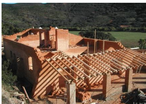
Figura 2.5 - Construção de habitação em BTC (Carrapateira)
