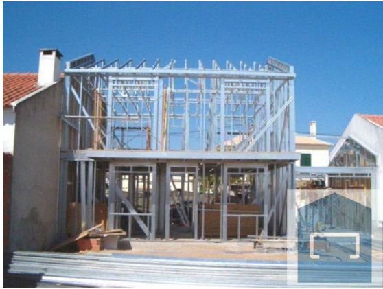
Figura 1 – Estrutura metálica da habitação
