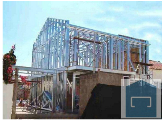
Figura 2 – Estrutura metálica da cobertura
