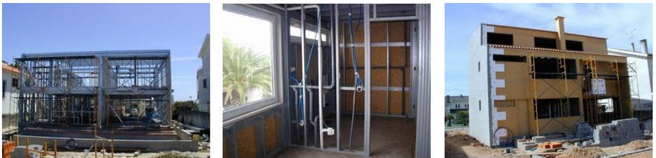
Figura 2.17 – Processo construtivo de moradia unifamiliar pelo sistema LSF em Ílhavo
