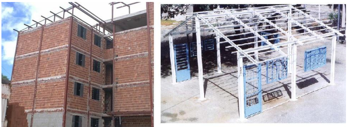
Figura 4.4 - Exemplo de habitação multifamiliar e unifamiliar da empresa USIMINAS
