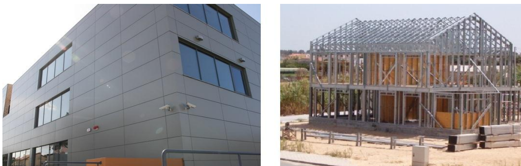
Figura 2.10 - Exemplos de aplicação de fachada em alumínio e estrutura em aço leve na construção
