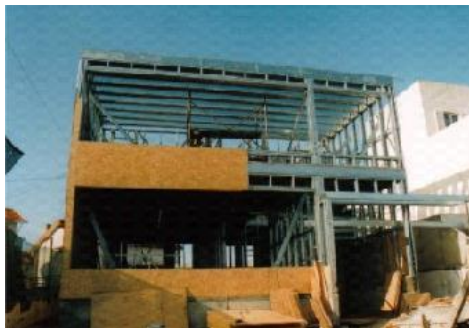
Figura 3.9 - Aplicação do revestimento estrutural [45]
