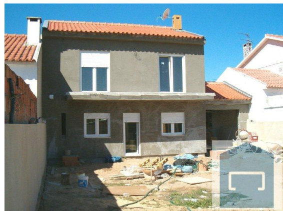
Figura 4 – Colocação de sistema ETICS
