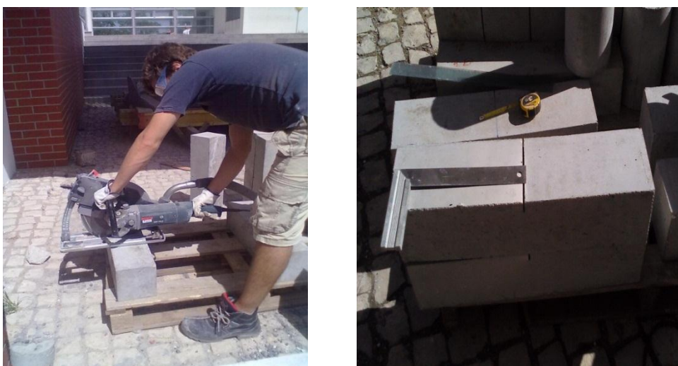
Figura 4.15 – Realização do corte nas vigas.
