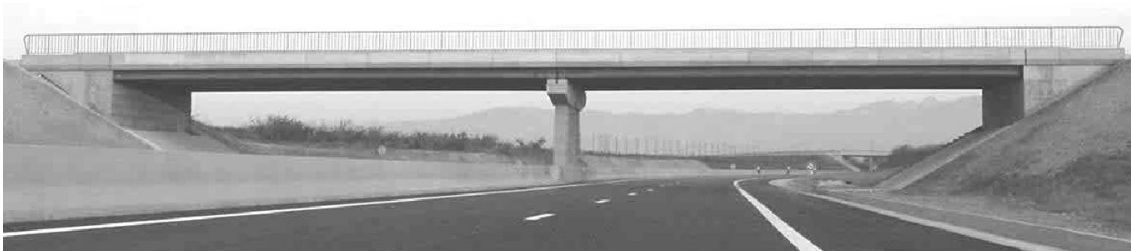
Figura 2.25 – Viaduto situado em Bourg-lès-Valence constituído por BRFA [54].
