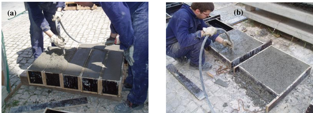
Figura 4.14 – Vibração das misturas, (a) vibração do betão nas vigas e (b) vibração do betão nos painéis.
