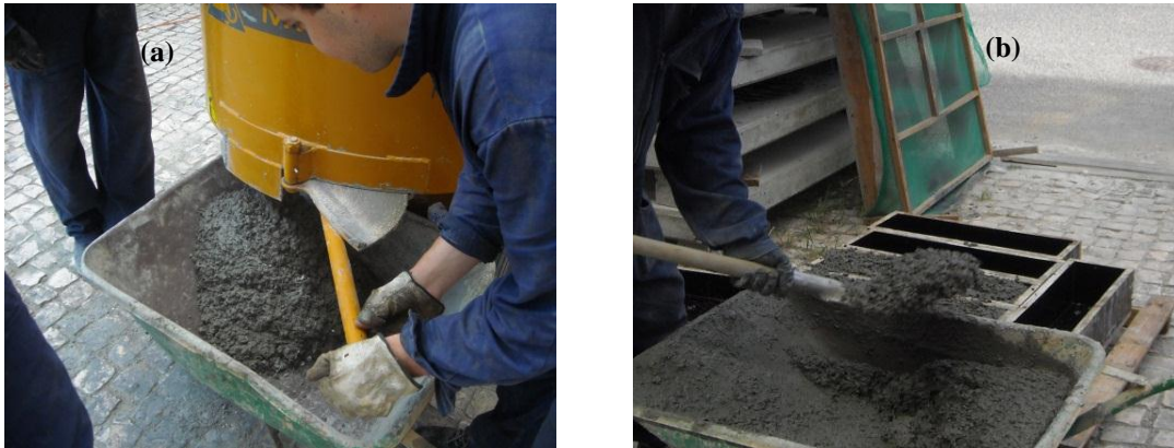
Figura 4.13 – Betonagem dos provetes, (a) transferência de betão da betoneira para o carro de mão e (b) enchimento dos moldes com pá.
