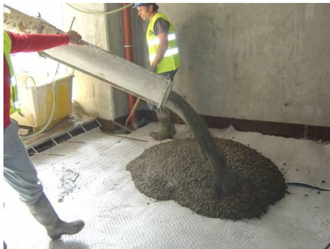
Figura 2.21 – Lançamento de BRFA na execução de um pavimento térreo [45].
