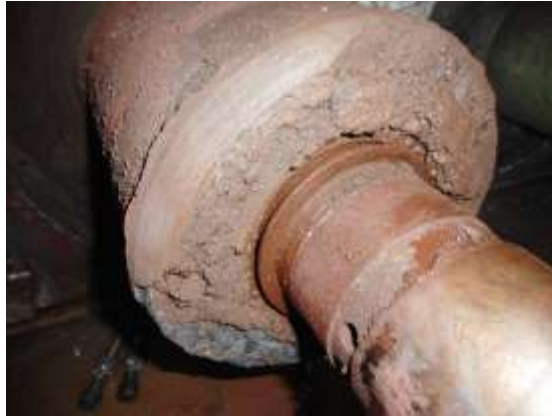
Figura 5.6 - Acumulação de óleo na cabeça devido a fuga
