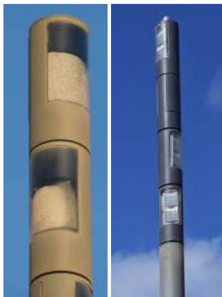
Foto 15 – Aspeto das Luminárias antes e após a intervenção
