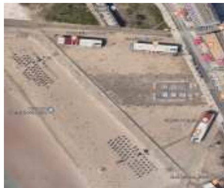
Foto 5 - Praça Central no Paredão
