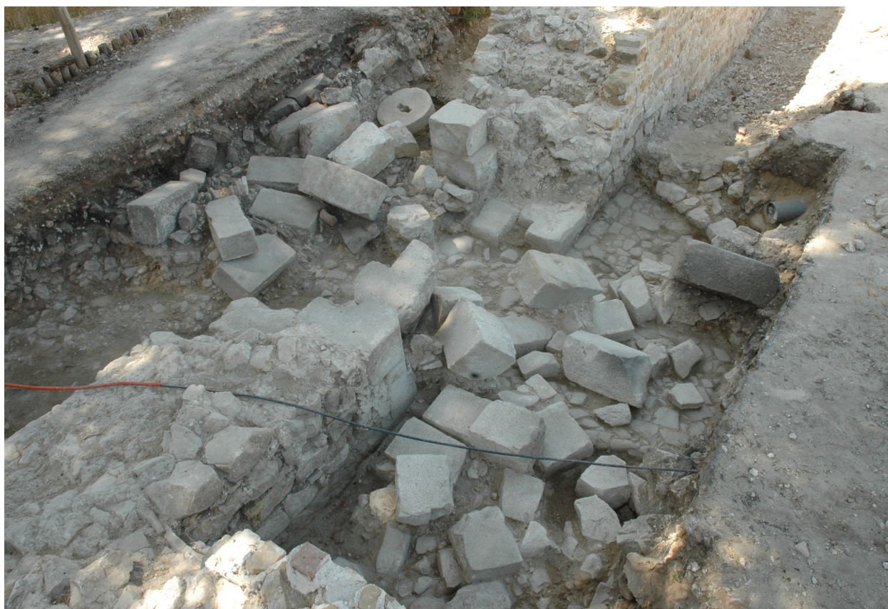
32. Destruction de la porte riveraine.
