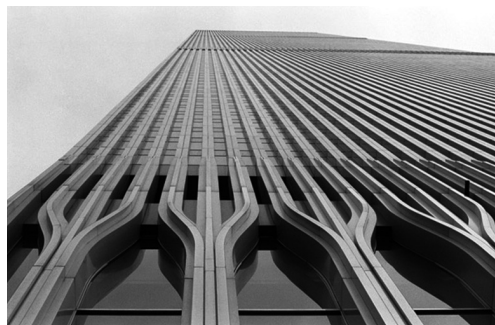
Fig. 5 - Fachada revestida a alumínio de prata Alcoa, Foto de iStockPhoto por Daniel Stein
