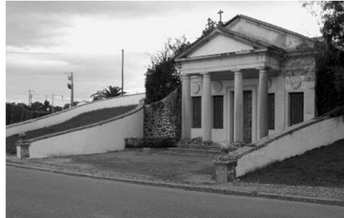
Fig. 4 - Vista da Capela de Nossa Senhora do Rosário onde se pode observar o arranque das duas rampas simétricas
