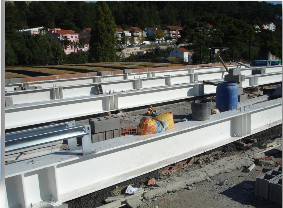
Estrutura de reforço da laje da cobertura
