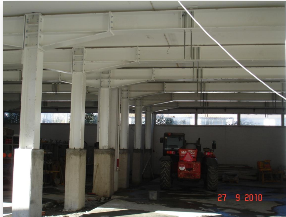
Estrutura metálica no piso térreo
