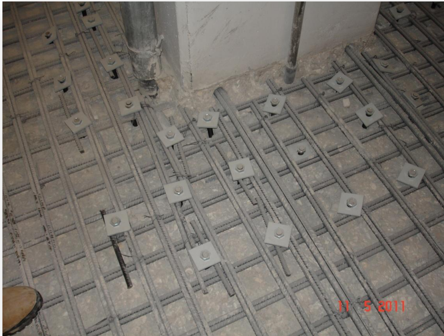
Vista superior da laje
