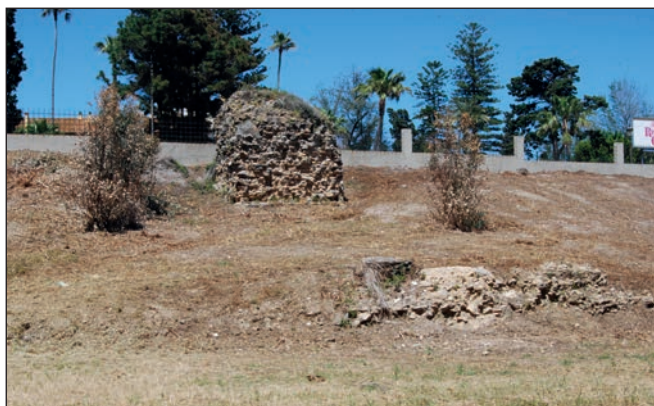
Fig. 2 – Restos de barbacana y bastión de la muralla de la “Villa Vieja” de Algeciras.
