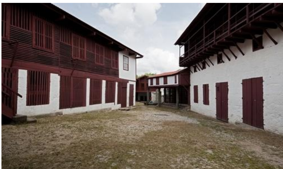
Figura 2 - O edifício onde está alojado o Centro Ciência Viva de Guimarães. Em cima, as ruínas da antiga fábrica de curtumes e a sua posterior reabilitação para acolher o centro de ciência (em baixo). Os créditos das imagens pertencem a Paulo Pacheco e à Agência Ciência Viva, respectivamente.
