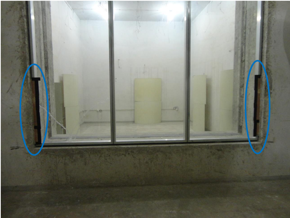
Figura 6.7 - Placas e fita adesiva utilizadas para vedar as faixas laterais
