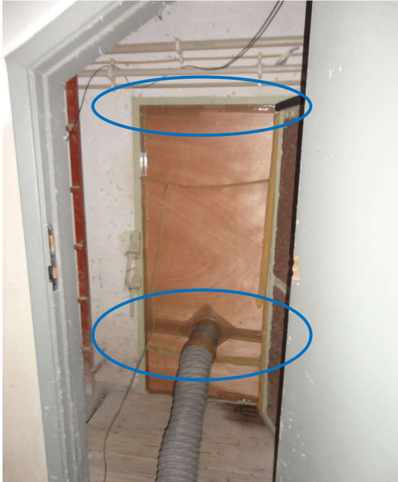
Figura 6.5 - Contraplacado com fita adesiva para tornar as juntas estanques
