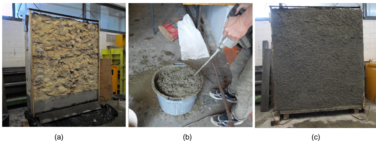
(a) colocação das régua de madeira e humedecimento do murete; (b) execução do microbetão; (c) aplicação da mistura
