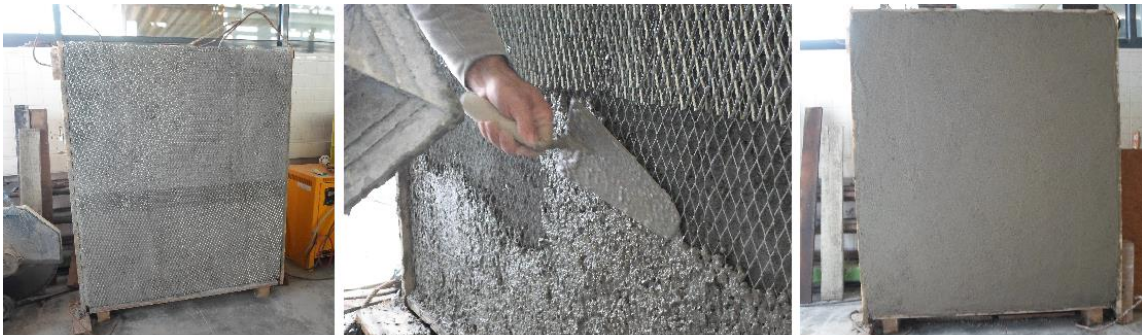
Figura 4.4 – Aplicação da segunda camada de microbetão
