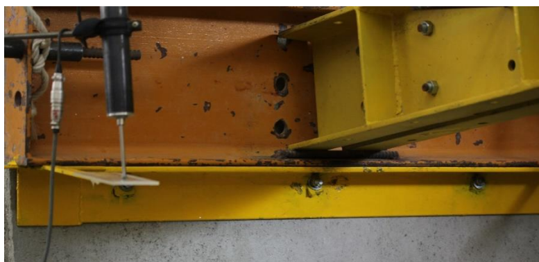
Figura 5.6 – Utilização de anilhas complementares nas pregagens
