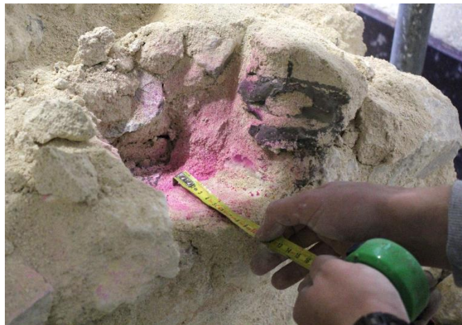
Figura 4.18 – Determinação da profundidade da carbonatação no murete
