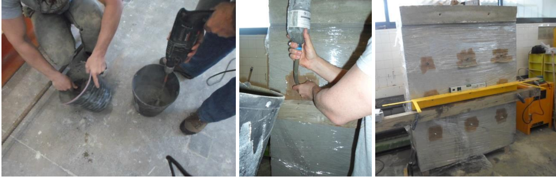
Figura 4.7 – Execução das pregagens
