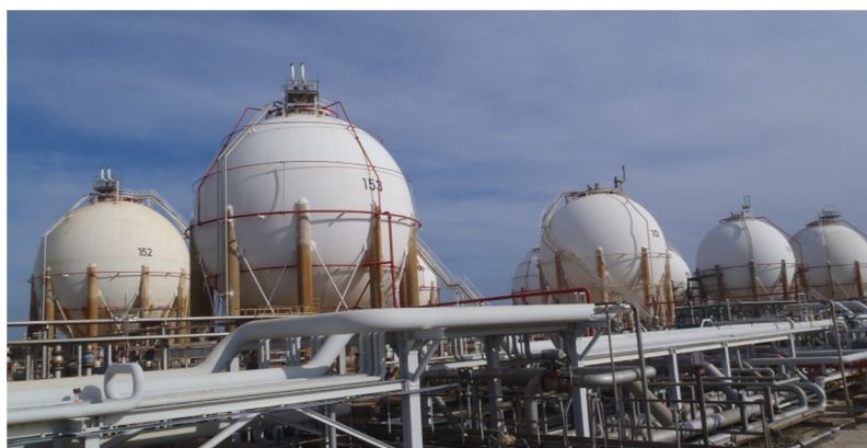
Figura 15 – Esferas para armazenagem de propileno totalmente pressurizadas
