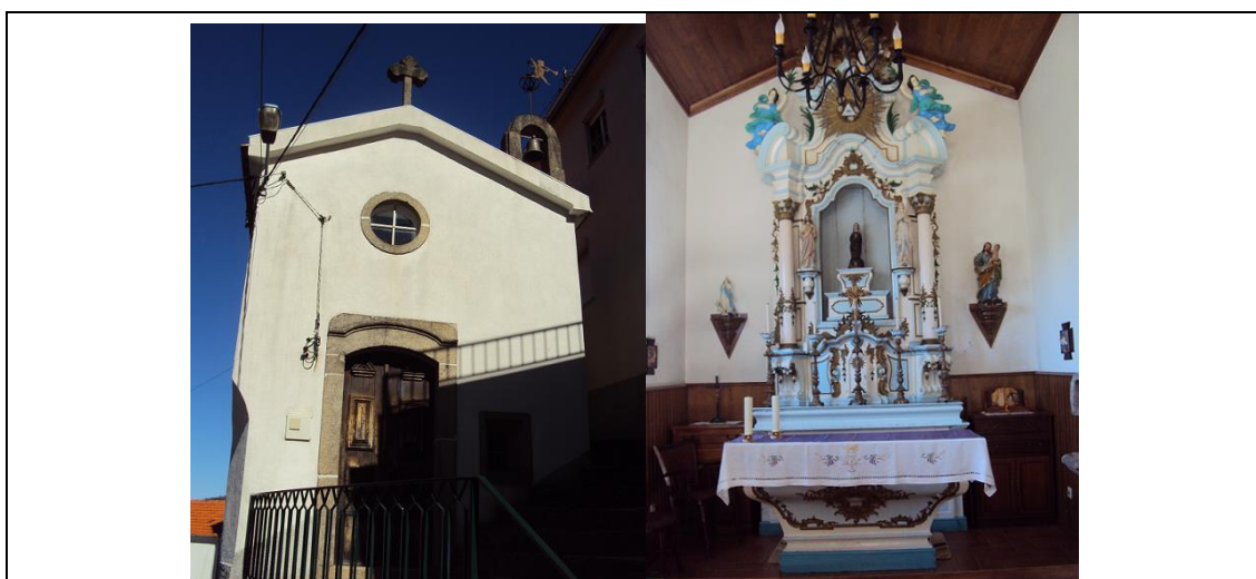
Figura 1 – Capela de Nossa Senhora da Conceição
