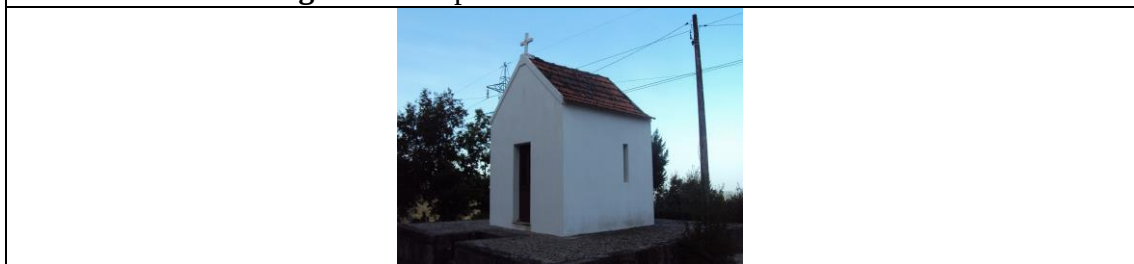
Figura 2 – Capela do Nosso Senhor dos Aflitos
