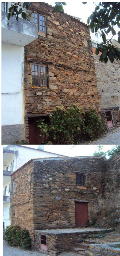
Figura 1 – Estrutura Habitacional Vernacular denominada Casa de D. Dinis
