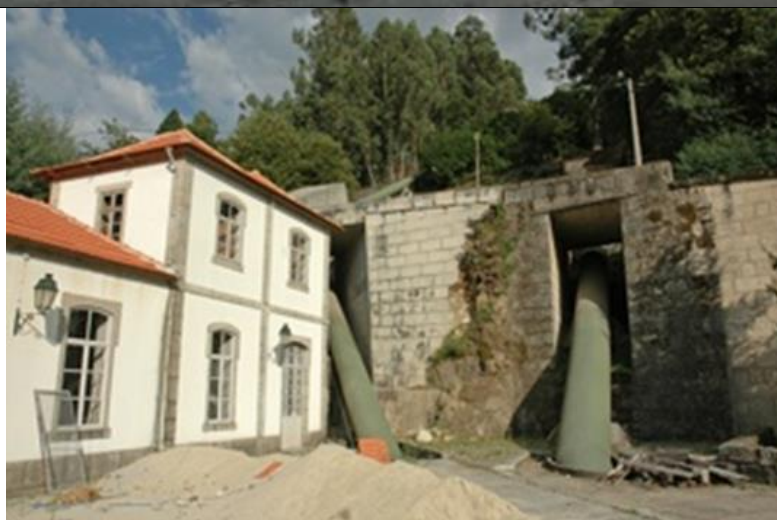
Figura 1 – Central Hidroelétrica da Senhora do Desterro
