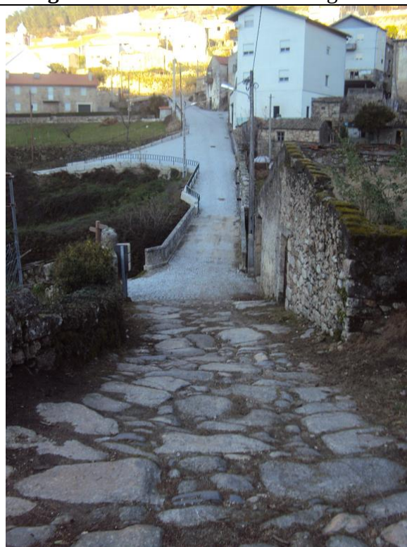
Figura 2 – Pavimento da ponte
