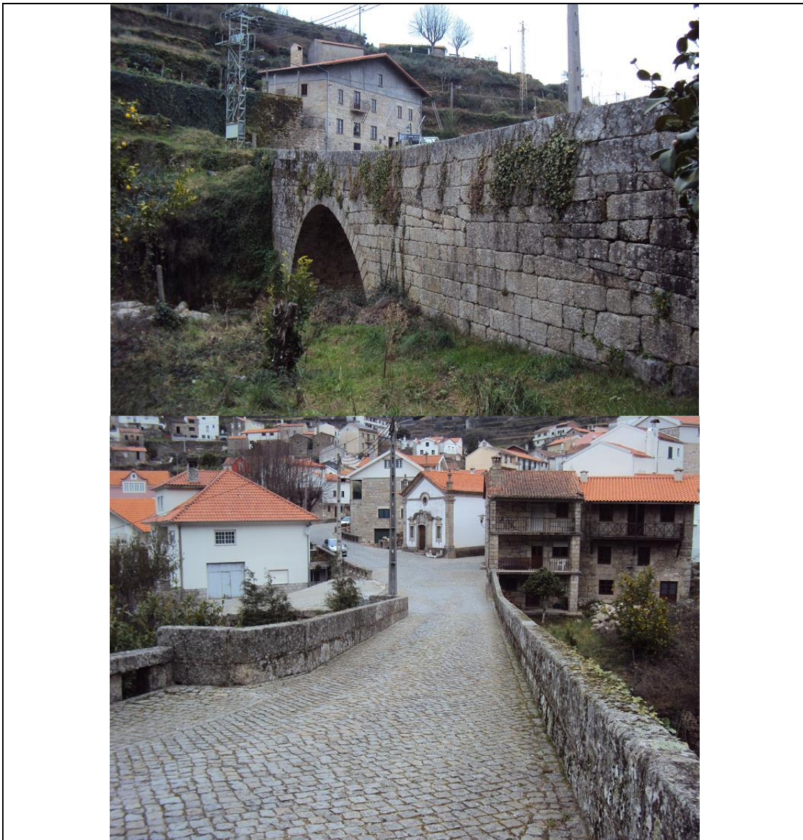
Figura 1 – Ponte em cantaria de granito
