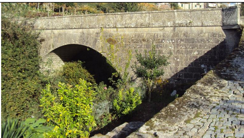
Figura 1 – Ponte em cantaria de granito
