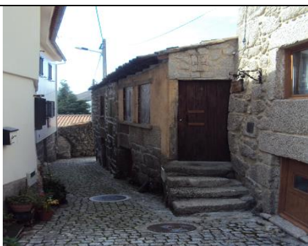
Figura 1 - Casa de habitação vernacular denominada D. Dinis
