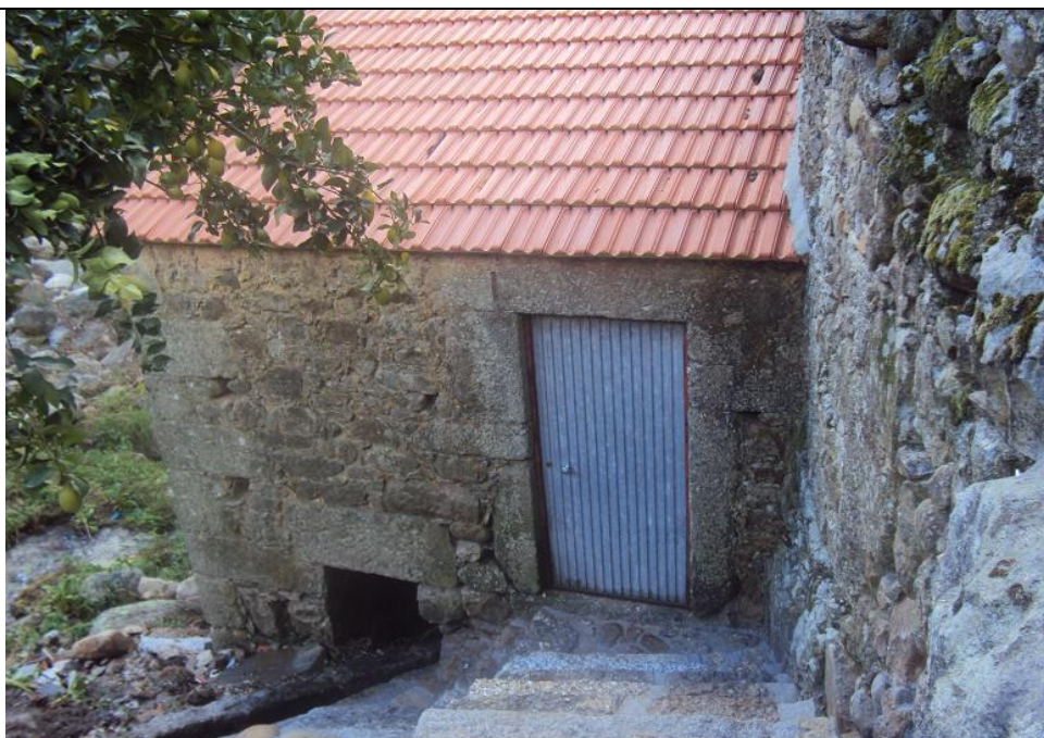
Figura 1 – Moinho (I) da Rua da Levada
