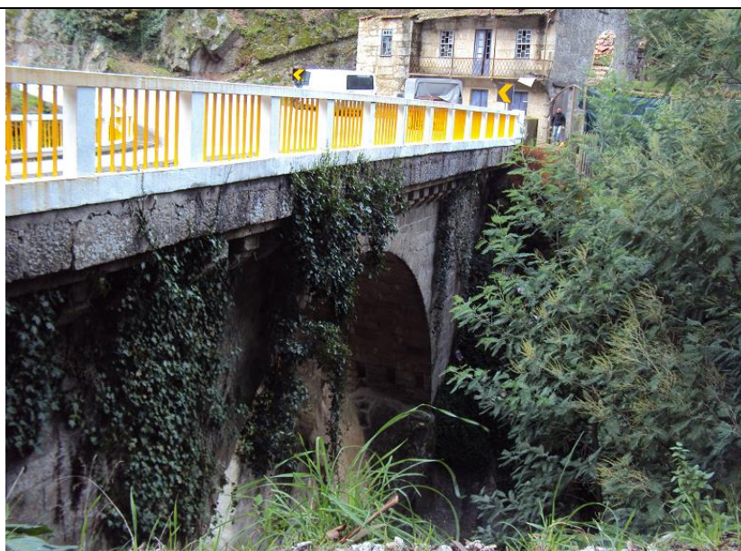
Figura 1 – Ponte de Jugais
