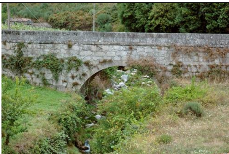
Figura 1 – Ponte da Rua do Porto
