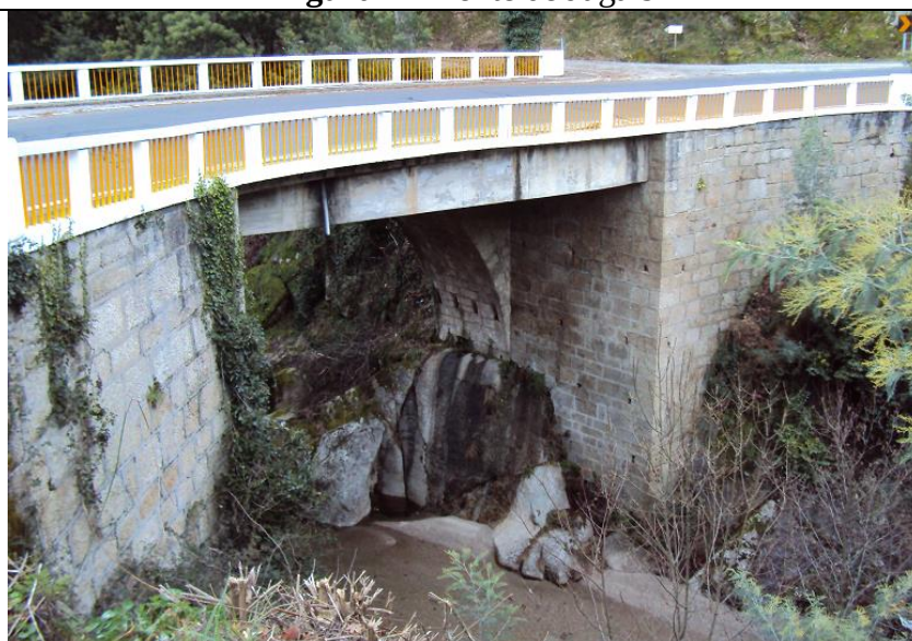
Figura 2 – Ponte de Jugais
