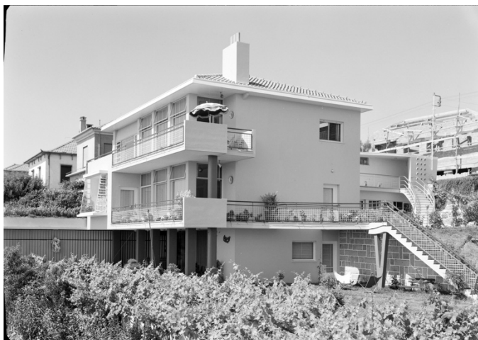
fig. 3 Arménio Losa e Cassiano Barbosa Casa António Neves Vista exterior, ca. 1949 Col. Estúdio Mário Novais | Biblioteca de Arte Gulbenkian CFT 003.67381
