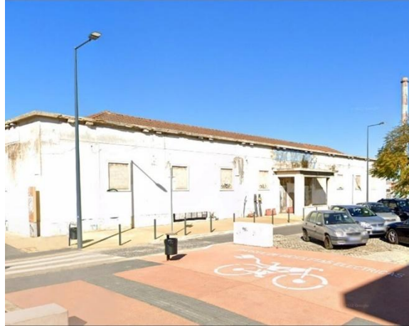
Fig. 20- Armazém de Víveres, antes das obras de reabilitação.
