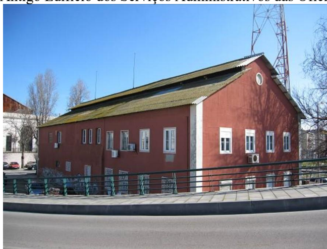
Fig. 16- Antigo Edifício dos Serviços Administrativos das Oficinas da CP
