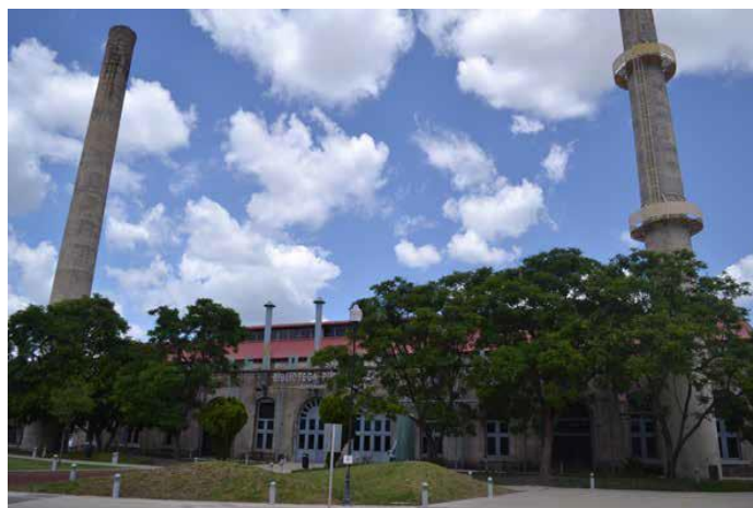
Fig. 34- Edifício da antiga central elétrica do complexo adaptada a biblioteca pública
