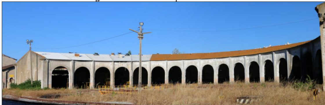
Fig. 10- Rotunda das Máquinas do Barreiro
