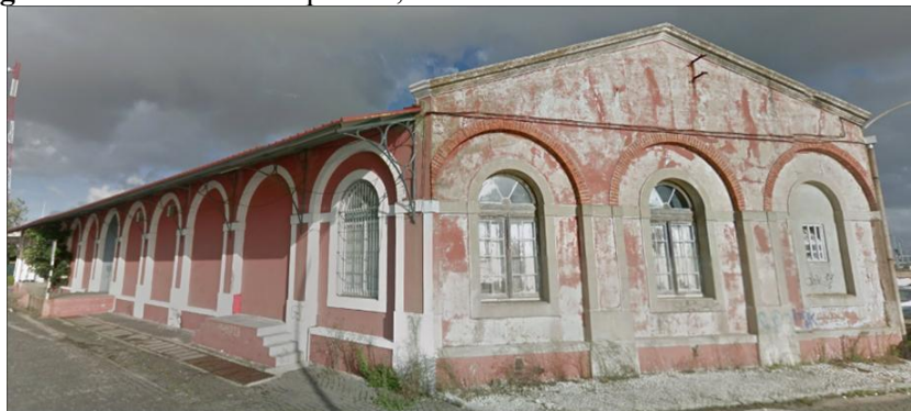
Fig. 19- Armazém de Despachos, Telheiro de Mercadorias e Cais da Cortiça
