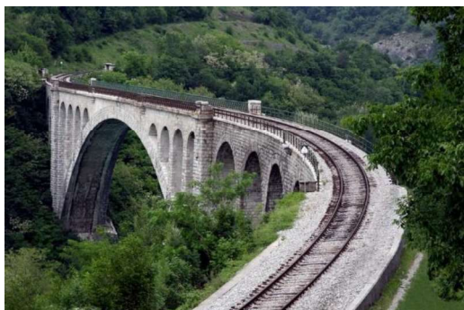
Figura 3.1 - Transição entre aterro e ponte
