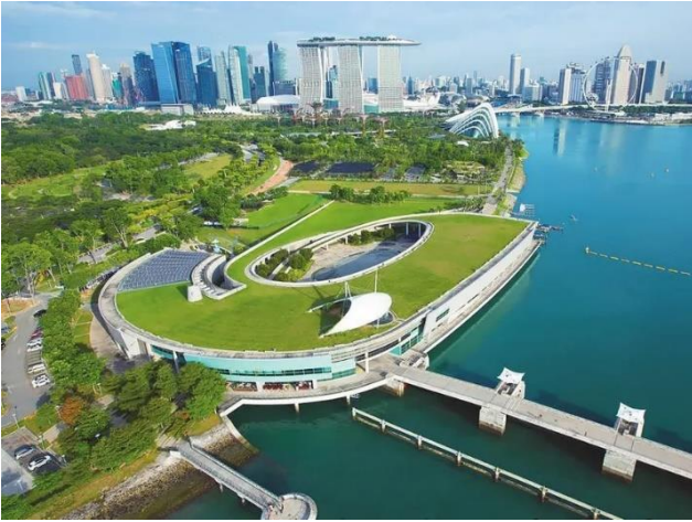
Figura 3.35- Marina Barrage, Singapura («Marina Barrage», sem data)
