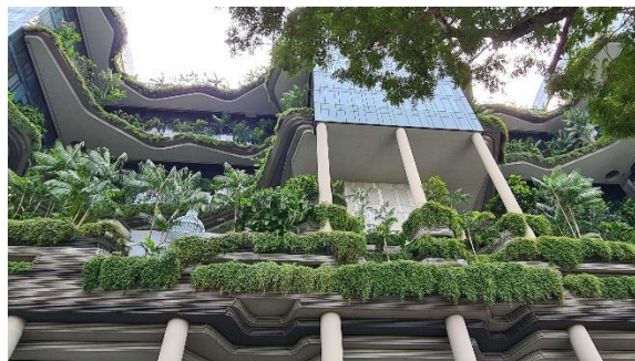
Figura 4.6- Cobertura e terraços verdes, Singapura (Rooftop Greenery, sem data)
