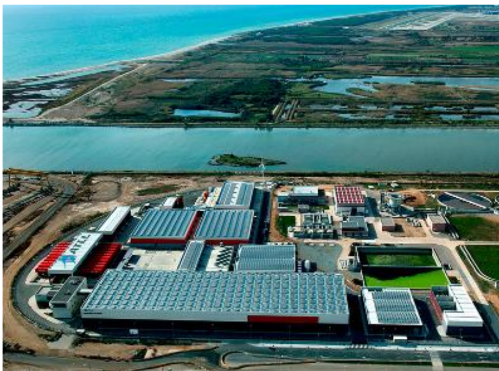
Figura 3.18- Central de dessalinização de Barcelona "Desalinizadora del Prat"
