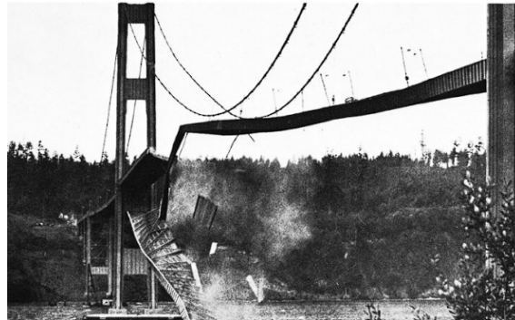
Figura 2.12: Queda da Ponte de Tacoma devido ao efeito do vento que não foi considerado durante a fase de projeto [11].
