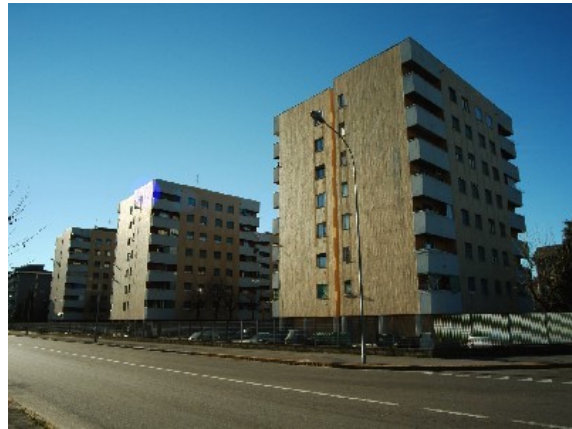
Figura 3.3: Quartiere Sant'Eusebio: Cinque Torri , fotografia do conjunto das três torres Este.
