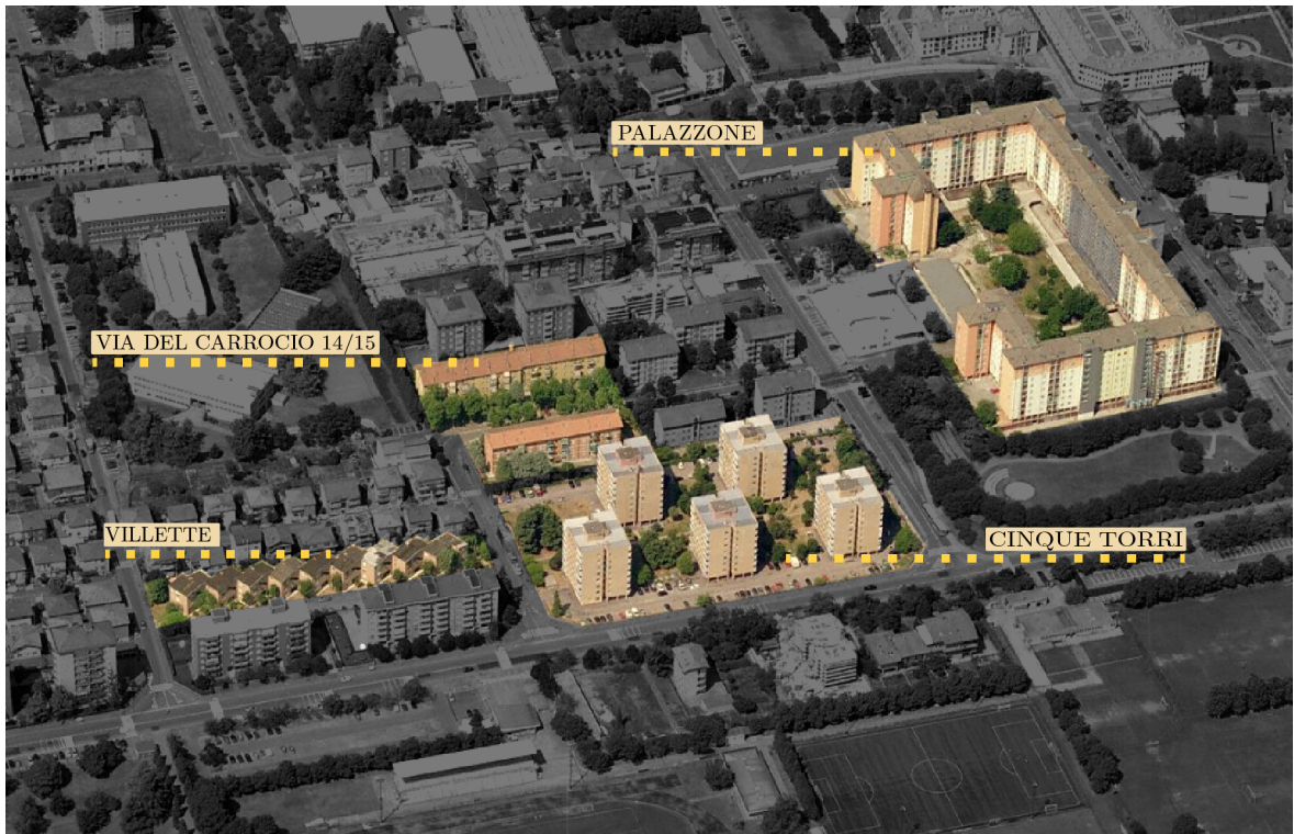
Figura B.2: Quartiere Sant' Eusebio : Vista aérea de alguns edifícios de habitação social. Fonte: (Microsoft, 2016).
