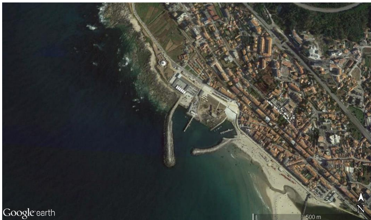
Figura 5. 2- Fotografia aérea do Portinho de Vila Praia de Âncora (Google Earth © 2006)
