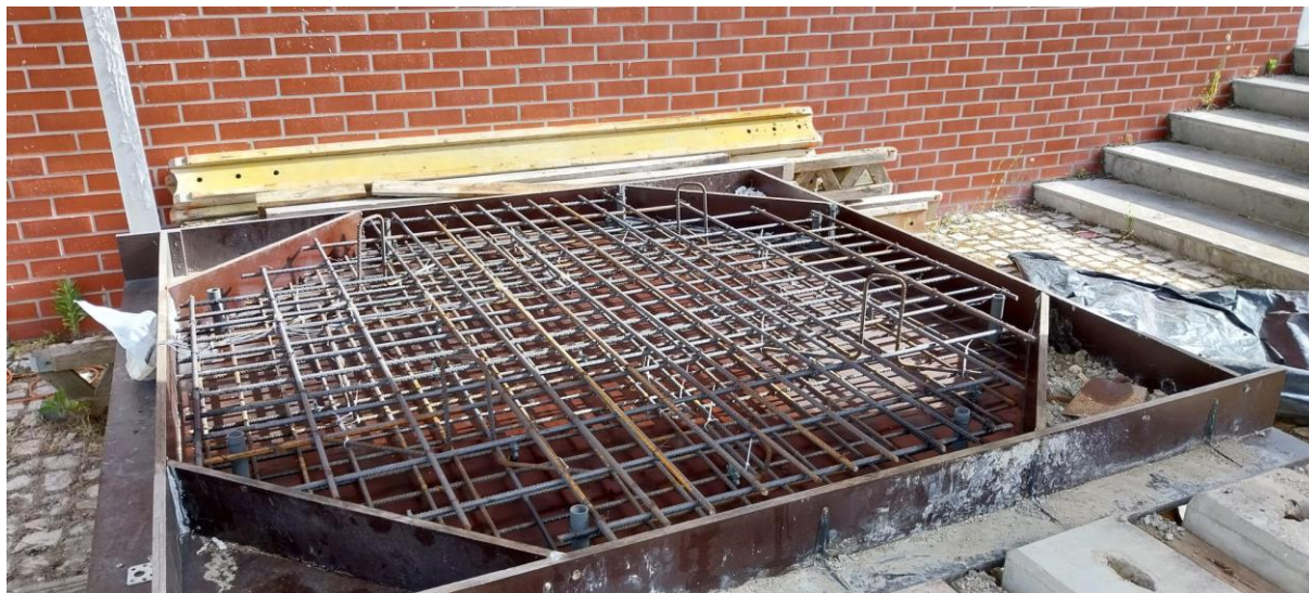
Figura 3.6 - Armadura da laje
