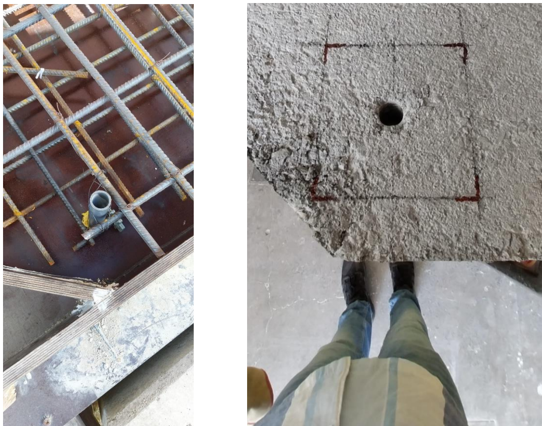
Figura 3.10 - Zona do tubo antes e após a betonagem
