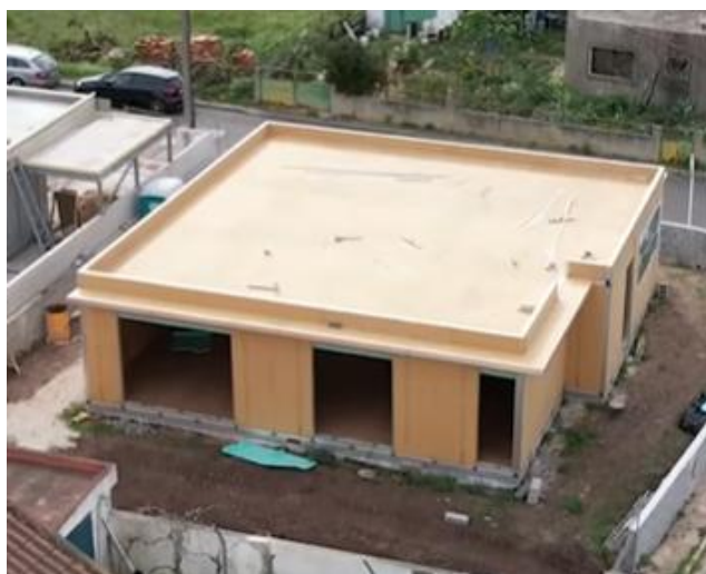
Figura 5.2 - Casa de Loures - Envolvente composta pelos painéis modulares da ModTech [33]
