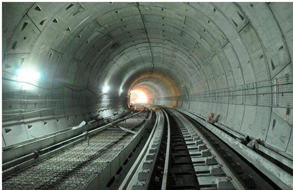
Figura 2.6 - Exemplo de via em laje do ML, São Sebastião - Alameda (Infraestruturas, 2024)
