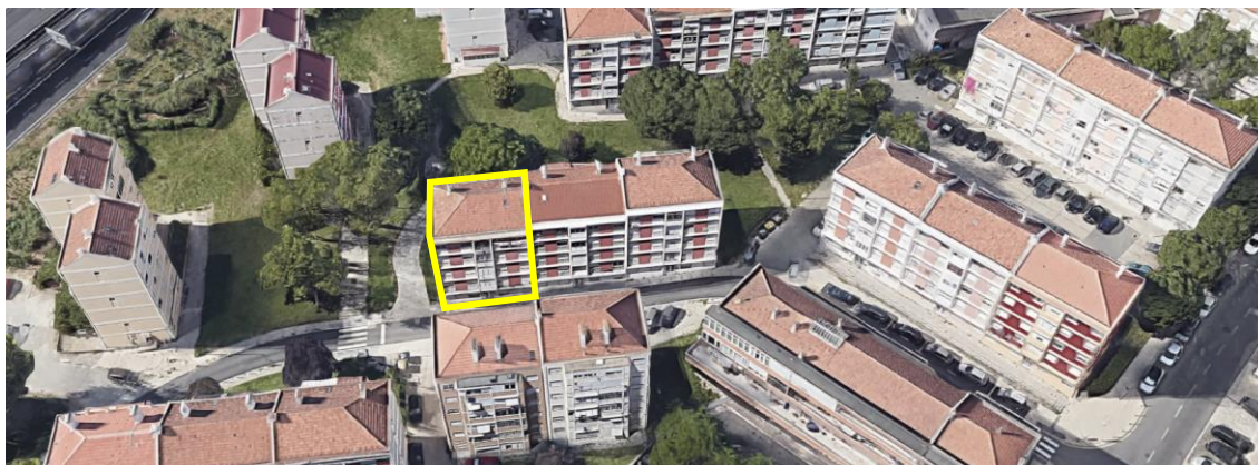
Figura 4 – Vista aérea da fracção em estudo no Bairro da Pedralvas, Edifício n.º12, Rua 5
