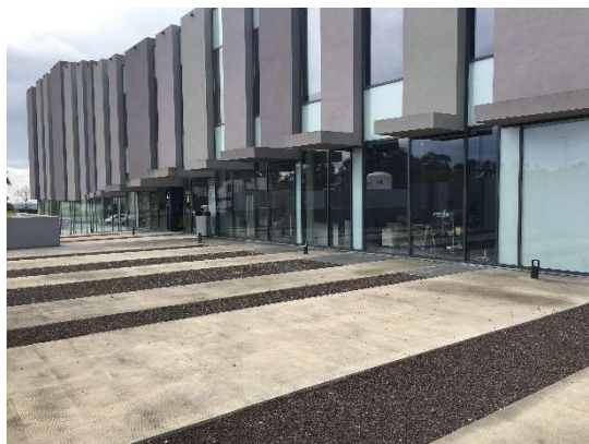
Figura 6 - Vista para o HDO a partir do exterior. Fonte: Elaboração própria.
