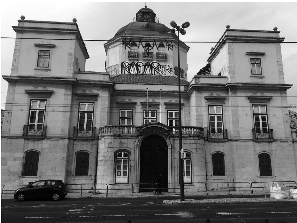
Figura 1 – O Palácio Burnay, onde funcionou o ISCSPU/ISCSP, na atualidade.
