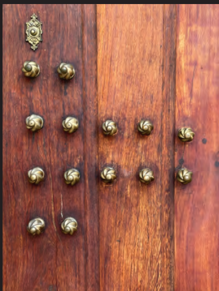
Fig. 16 Pormenor das ferragens da porta principal da Biblioteca
