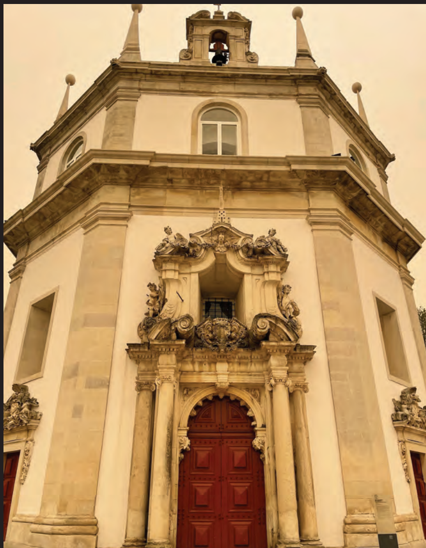
Fig. 59 Fachada da igreja do Senhor das Barrocas. Aveiro. © Sílvia Ferreira
