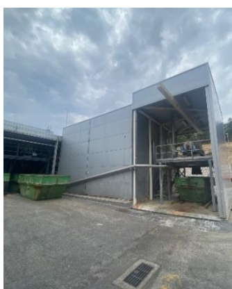
Figura 4.21 - Zona de contentores de lama
