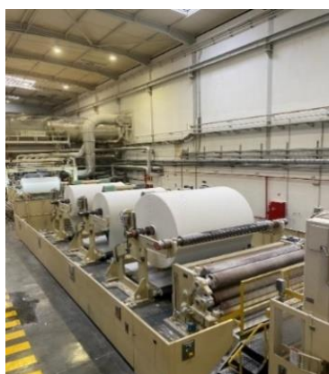
Figura 4.8 - Rebobinagem de bobines
