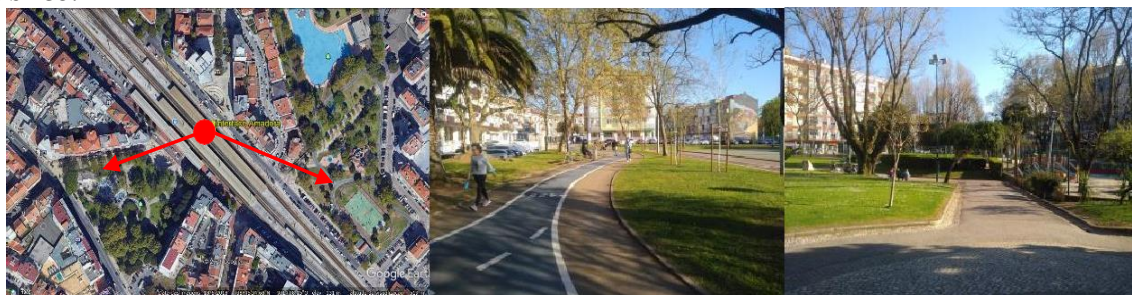
Figura 5.9 – Relação da interface como nó e o andar a pé na envolvente urbana.
