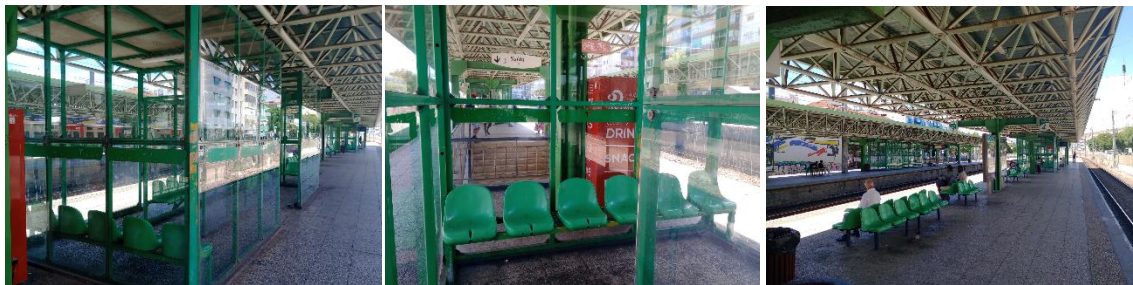
Figura 5.6 – Abrigo e assentos sobre a plataforma Interface da Amadora.
