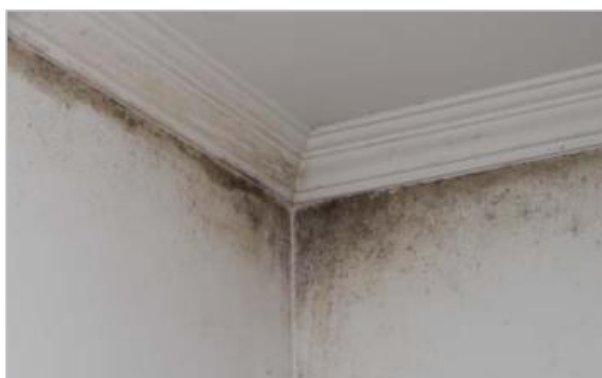
Figura 5.10. Ponte térmica linear. Fonte: [37]
