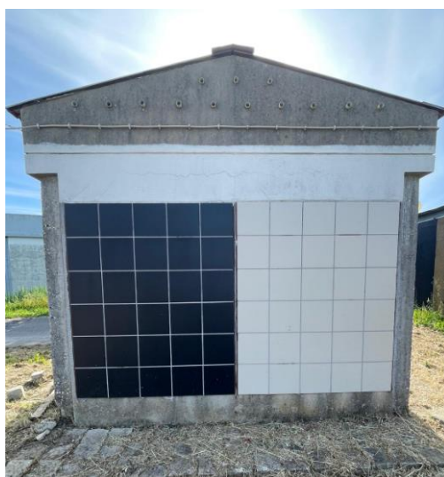
Figura 3.4- Ladrilhos cerâmicos de cor branca e preta no exterior da parede oeste.
