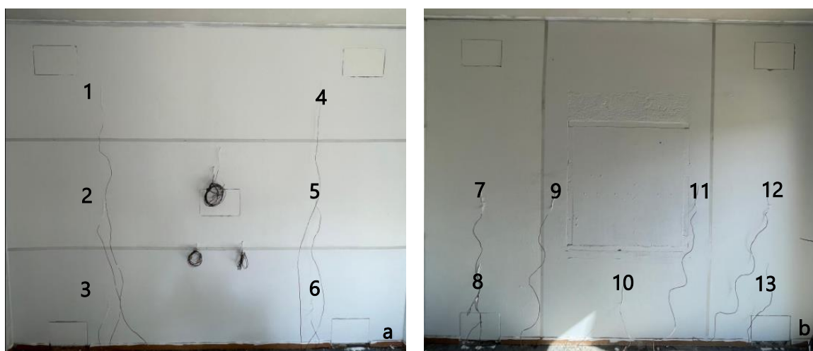
Figura 3.7- Posicionamento de termopares no interior da parede oeste (a) e norte (b).
