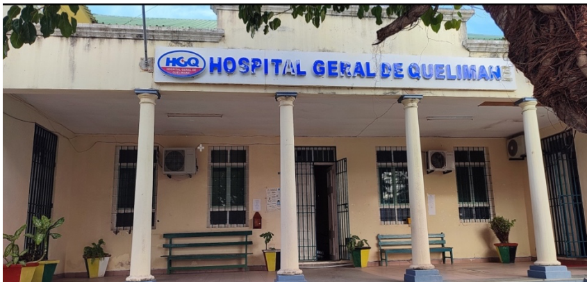
Figura 8. Hospital Geral de Quelimane
