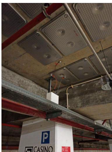
Figura 5.16: Cenário 2 - Instalação do grupo de PCM com mudança de fase a 15 °C
