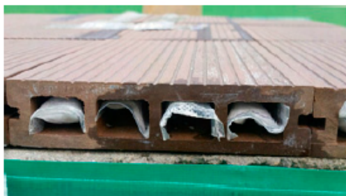
Figura 2.13: Pratos preenchidos com bolsas de PCM a colocar no telhado, Chung e Park 2017
