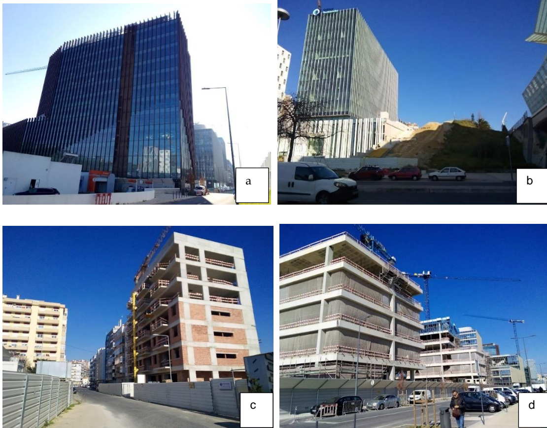
Fig. 4.12. Novos escritórios (a, b, d) concluídos/em obras e habitações (c) em obras.
