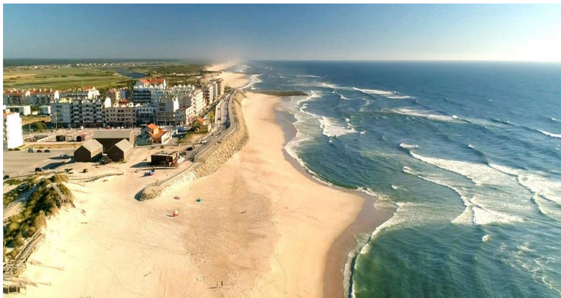
Figura 1.3 - Vista aérea da Praia da Vagueira e respetivas estruturas de defesa costeira. (fonte: Rota da Luz, 2023)
