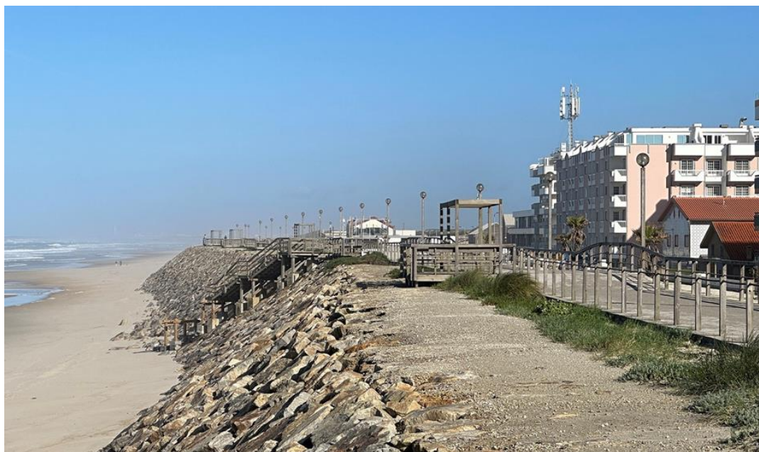
Figura 5.2 - Vista norte do paredão, da estrutura de defesa costeira Praia da Vagueira (11/01/2023).
