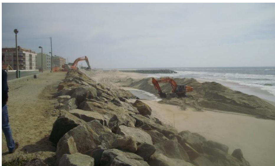
Figura 2.6 - Obra de reabilitação após o evento de 2008 (afundamento da fundação) (20/05/2009 - Coelho, 2014)
