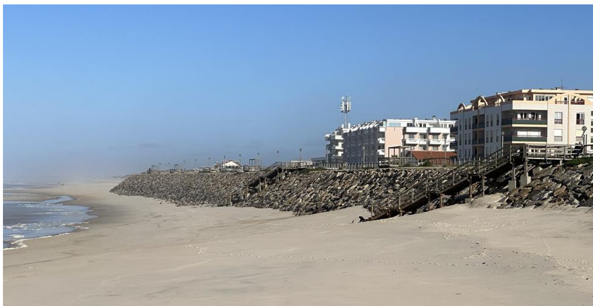
Figura 2.11 - Estrutura de defesa costeira longitudinal aderente, vista norte (11/01/2023)
