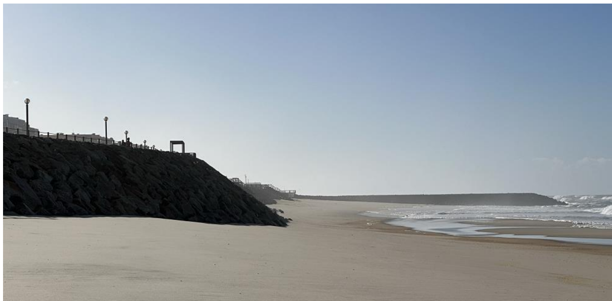
Figura 2.10 - Estruturas de defesa costeira Praia da Vagueira, vista sul (11/01/2023)
