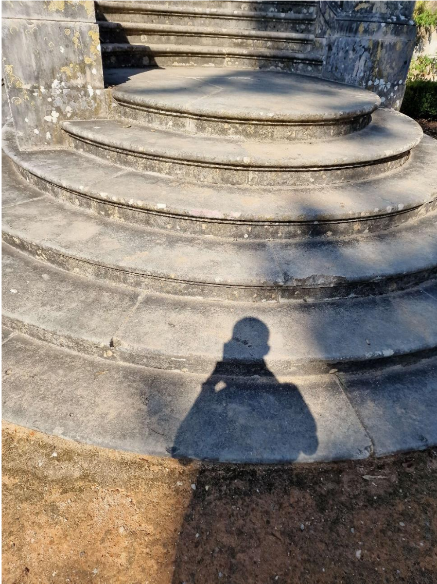
Figura 16 - Fotografia própria das escadas laterais junto à entrada da Calçada do Galvão, do Jardim Botânico da Ajuda.
