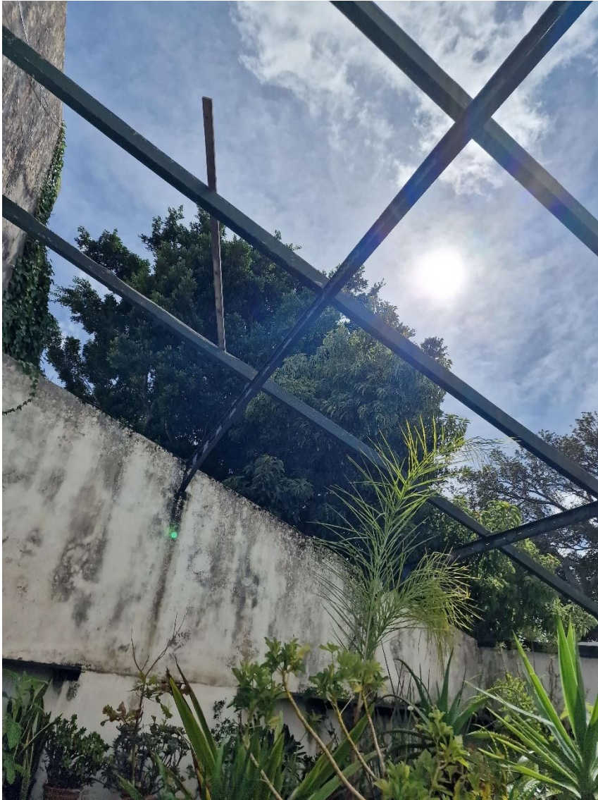
Figura 10 - Fotografia própria do telhado da estufa fria do Jardim Botânico da Ajuda.
