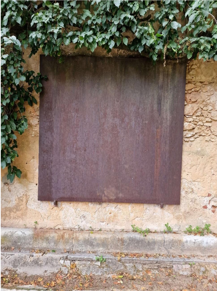
Figura 22 – Fotografia própria da estrutura de metal não identificada junto ao muro de suporte perto da entrada da Calçada do Galvão, no Jardim Botânico da Ajuda.
